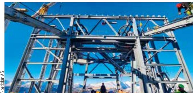
Fremre del av fjellstasjonen kragar ut over kanten på platået for at det skal bli nok høgde under kabinane, også ved mykje snø om vinteren. Montasje av sadlar med Super Puma helikopter.
