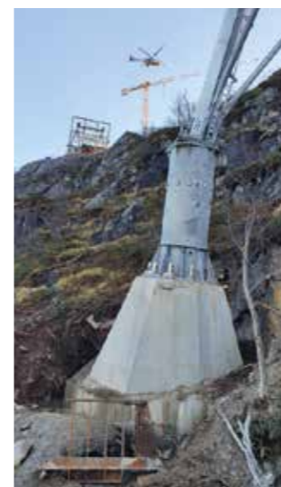
Mastefundament direkte forankra til fjell.
