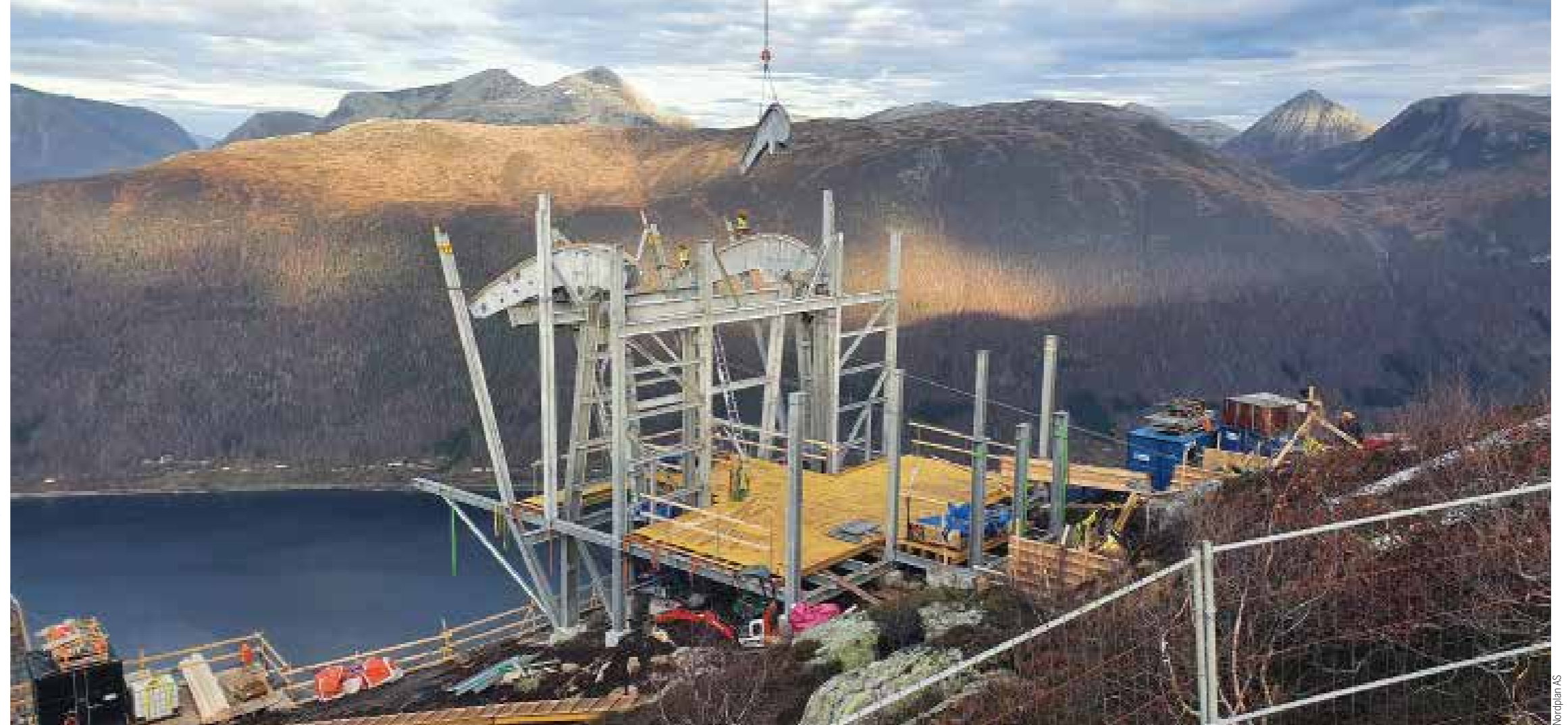
Fremre del av fjellstasjonen kragar ut over kanten på platået for at det skal bli nok høgde under kabinane, også ved mykje snø om vinteren. Montasje av sadlar med Super Puma helikopter.
