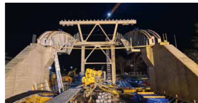
Sadlar montert på betongpullertar i botnstasjon.
