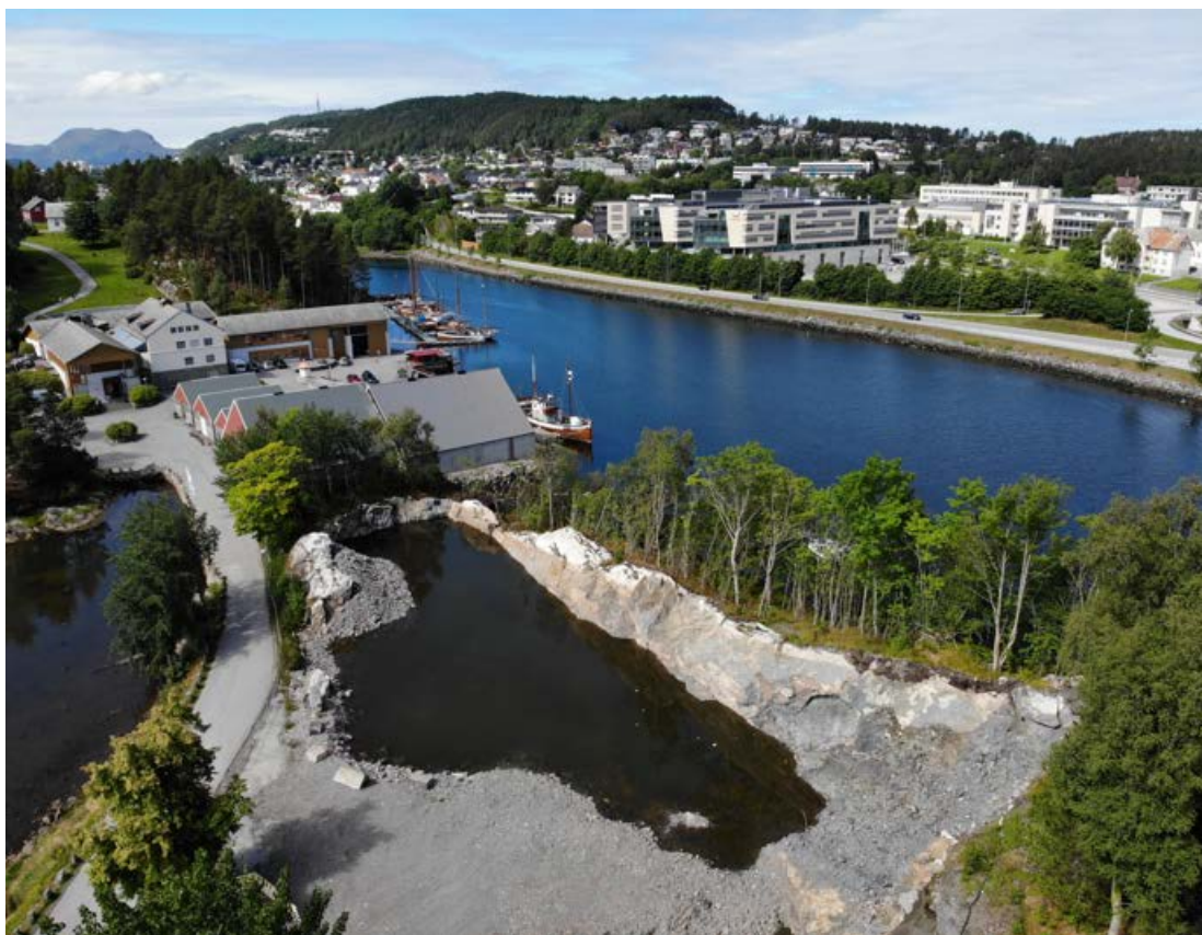
Dronebilde tatt mot vest, viser byggegroppen, tilkomstveg og bygninger ved museet.
