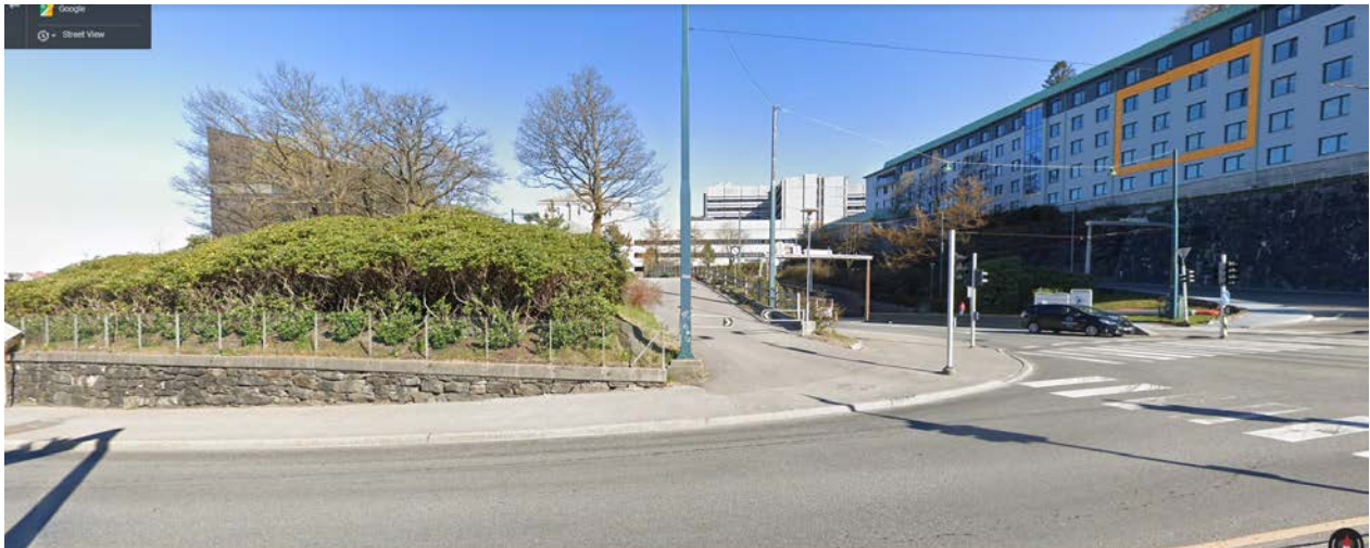
Over: kryssløsningen Ibsens gate x Haukelandsvegen. Armauer Hansens Hus til høyre i bildet. Under: Haukelandsvegen forgreiner seg også til Sentralblokkas. Sett fra Haukelandsvegen og bort mot det gamle ærverdige Konrad Birkenhaugs Hus (fredet, midt i bildet).
