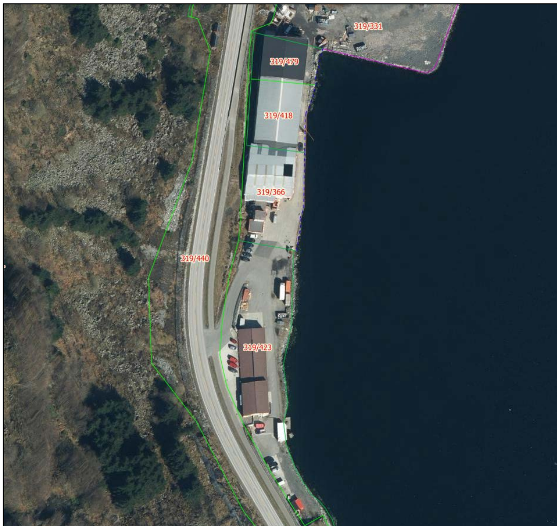
Bildet synar eksisterande situasjon og eigedomstilhøve i planområdet, med to industribygg, tilkomstveg plassert midt i mellom desse og kaiareal framfor industribygga lengst nord i utsnittet. Bildet er tatt frå spissen av fyllingsareal nord for planområdet (Norge i bilder, Kinn og midtre Sogn mellombels 2021).
