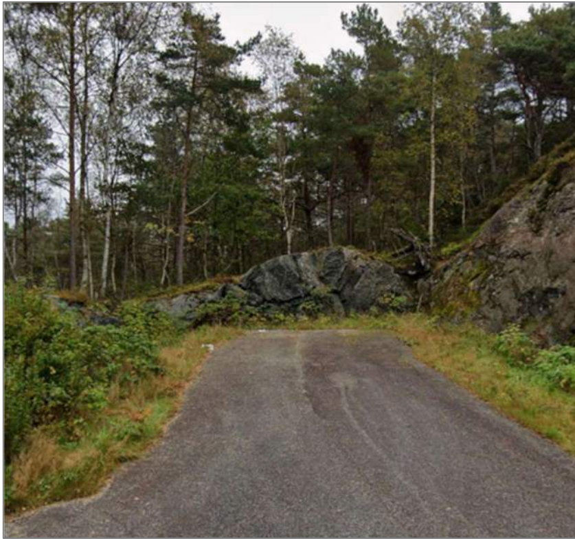
Figur 4 Etablert avkøyrsløp som leia inn til planområdet.
